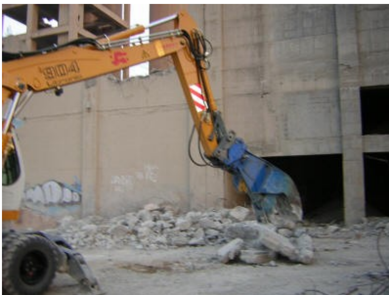
Рис. 4 Зубья на экскаваторе
