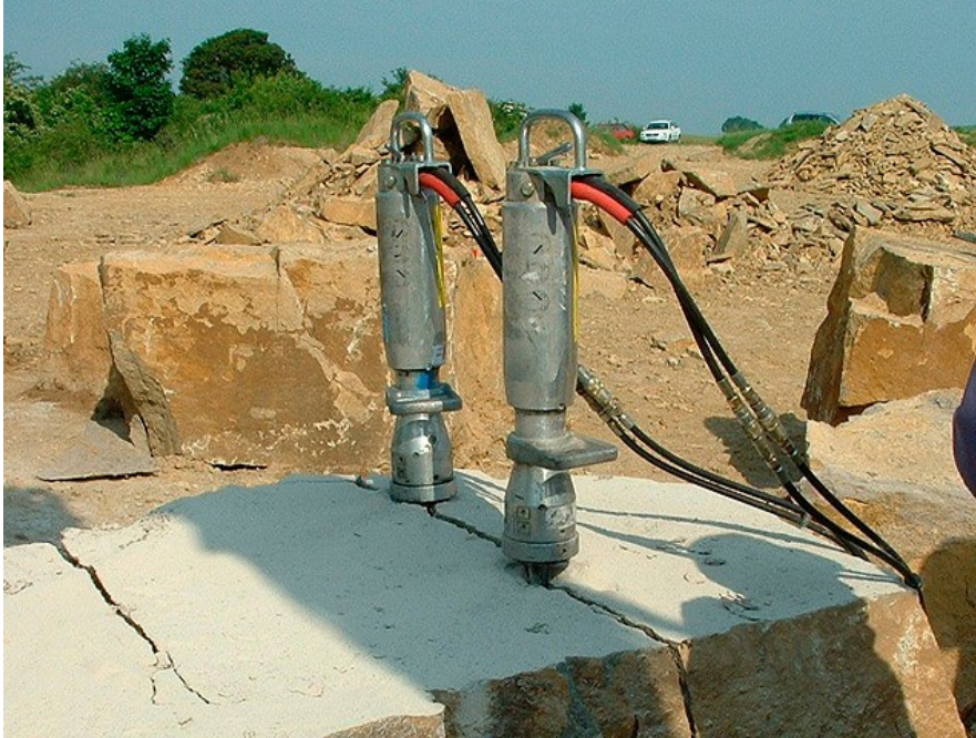
Рис. 2 Гидроклинья при раскалывании бетонных конструкций
