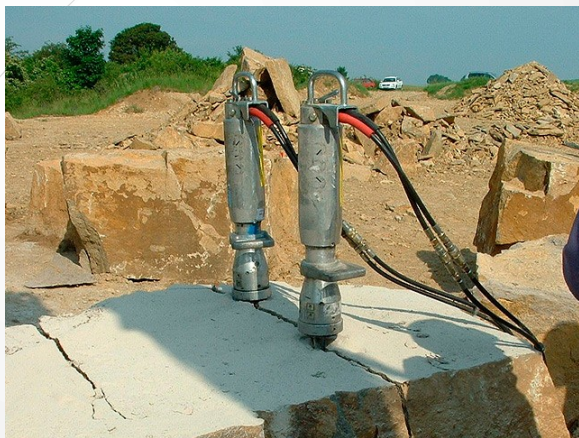
Гидроклинья при раскалывании бетонных конструкций
