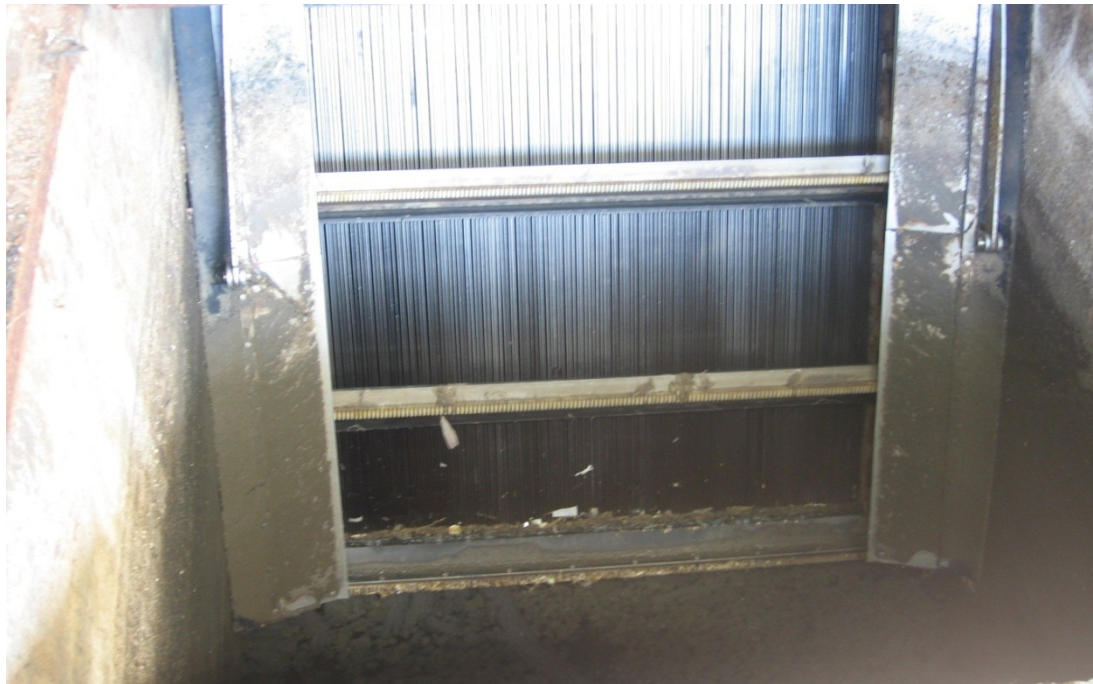
Решетка для задержания грубых отбросов с прозрамами 6 мм
