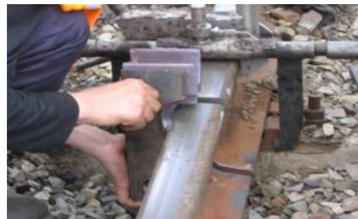
Фото 2. Производится установка литейных форм. Для придания форме герметичности швы замазывают специальным раствором.
