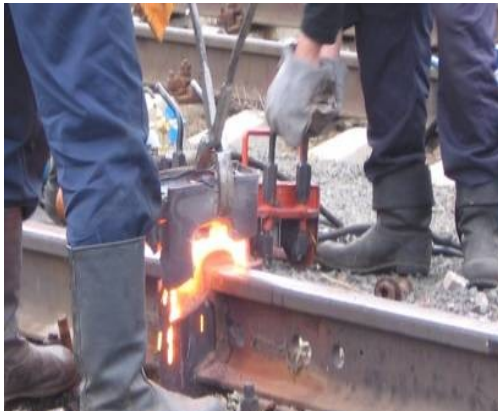
Фото 4. После снятия тигеля снимают литейные формы.Остатки литья снимают специальным приспособлением гратоснимателями в горячем состоянии.
