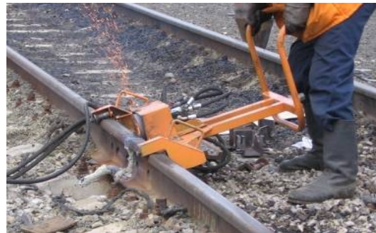
Фото 5. Поверхность сварного стыка шлифуют (обычно поверхность катания и боковая рабочая грань рельса).
