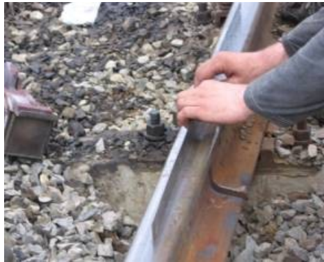
Фото 1.стыковой зазор соединяемых рельсов устанавливают шириной 25 +/- 1мм. Поверхности катания рельсов должны быть в одном уровне (проверяется металлической линейкой).
