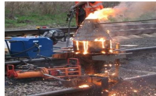
Фото 3. Смесь поджигают термитной спичкой и закрывают колпаком, так как температура разогрева компонента 2800-3000 °С.
