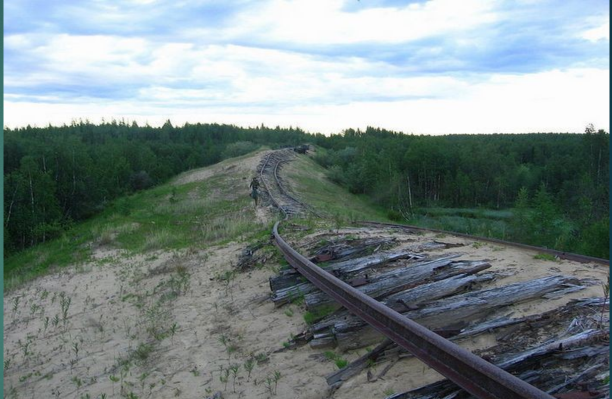
Современное состояние дороги Чум — Салехард — Игарка при пересечении бугристых ландшафтов
