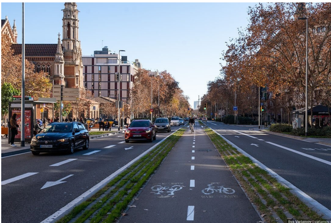
Рисунок 22 - Пример велодорожки в Барселоне на проезжей части
