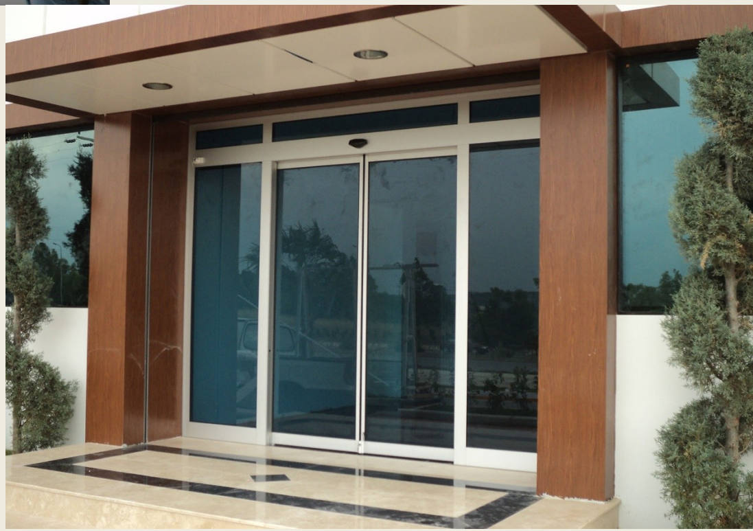
Пример раздвижных дверей на входе
