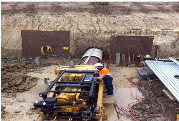
Рисунок 1.5 Прокладка труб по технологии Бурношnek
