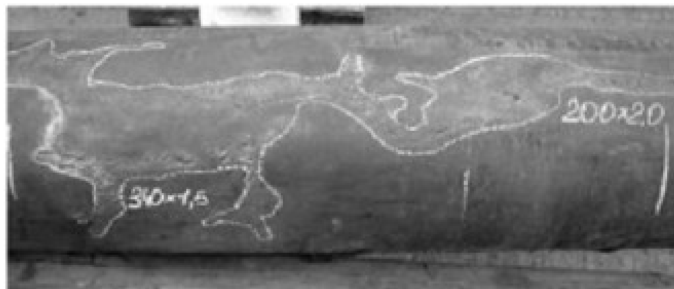
Зона трубы с коррозионными дефектами
